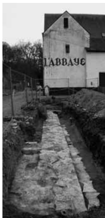
Dégagement de la façade méridionale de l'église (avril 2009).
