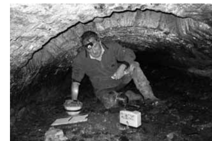
Relevé de la canalisation en pierre reliant les deux étangs en passant à travers le site (novembre 2008).
