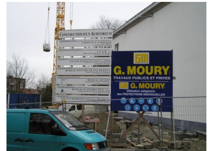
Construction (en cours) d'un auditorium pour l'académie de musique (rue des Ecoliers).
