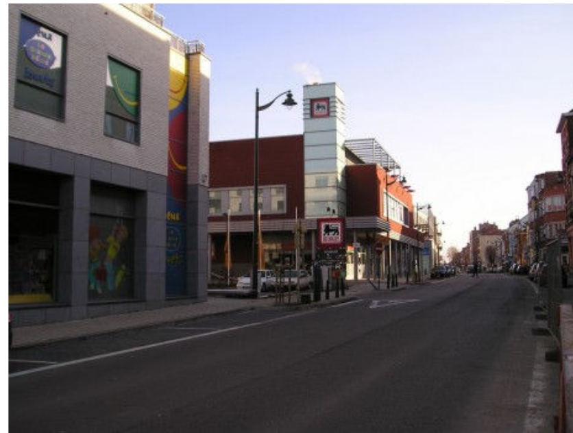
Re-développement du site Interbrew (chaussée de Wavre) en un pôle mixte de commerces, bureaux et logements (travaux en cours).
