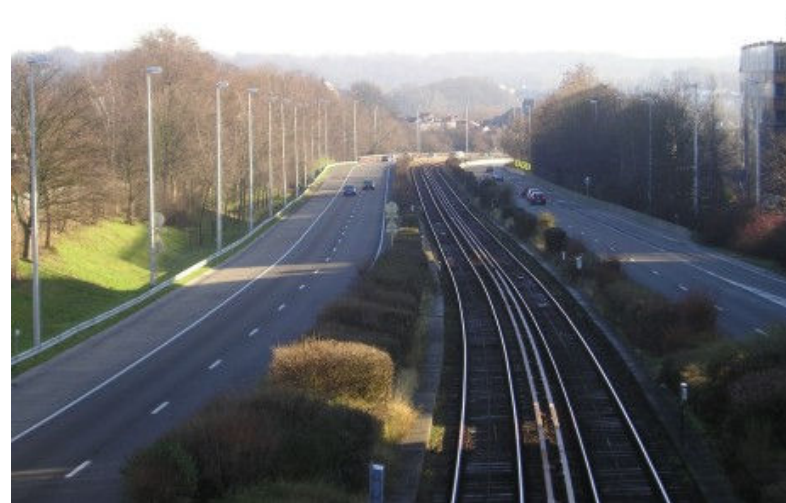
Le site Beaulieu : un débouché autoroutier (E411) mais également la ligne de métro 1A.
