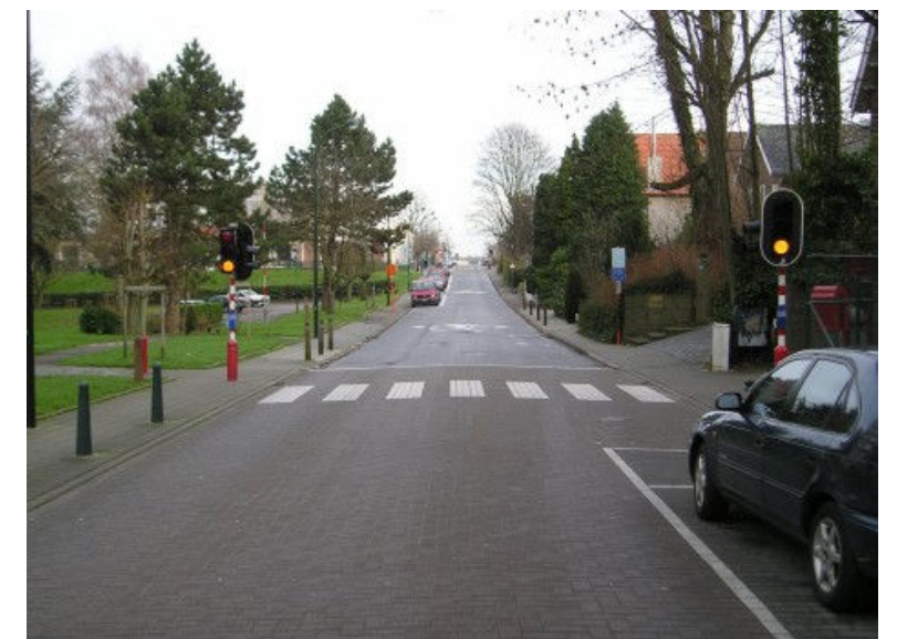
La proximité d'une école entraîne des aménagements de sécurisation spécifiques (ici un feu et un plateau avenue Van Horenbeeck).
