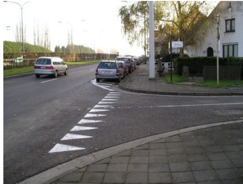
Chaussée de Wavre : une traversée non protégée et inadaptée pour les PMR (hautes bordures de trottoirs).
