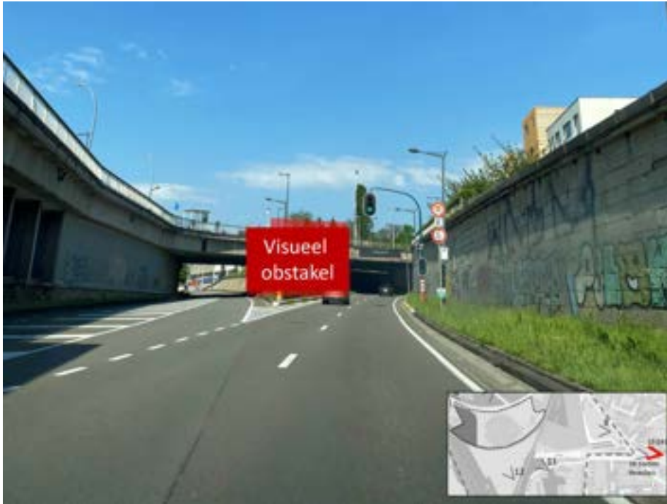
Afbeelding 42 Zicht nr. 15 (afb. CSD Ingénieurs, september 2023)
