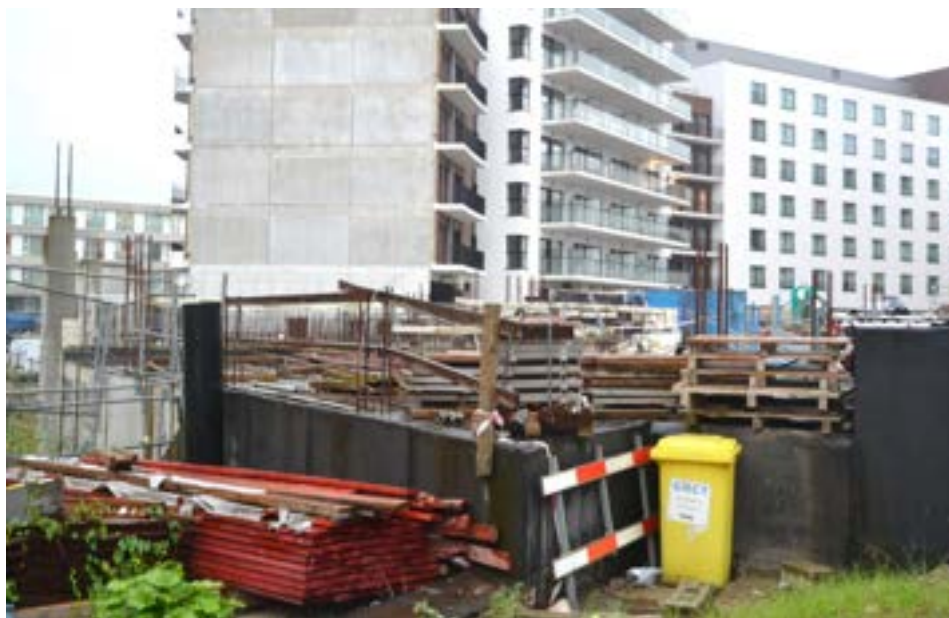
Afbeelding 63 Illustratie van de bouwwerken in uitvoering (afb. CSD Ingénieurs; 21 september 2023)
