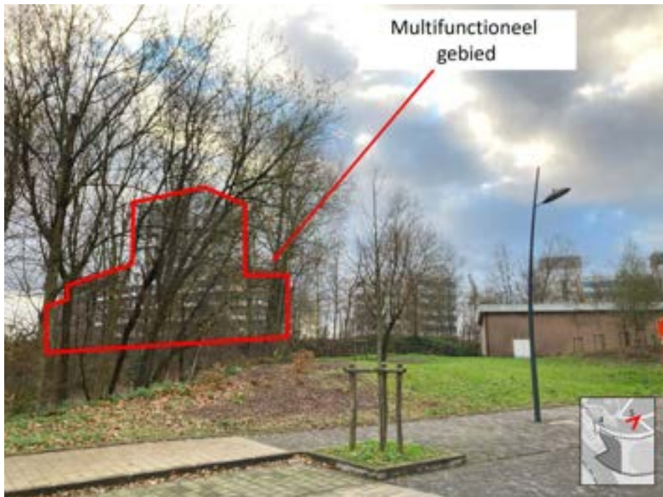
Afbeelding 32 Zicht nr. 5 (afb. CSD Ingénieurs, september 2023)
