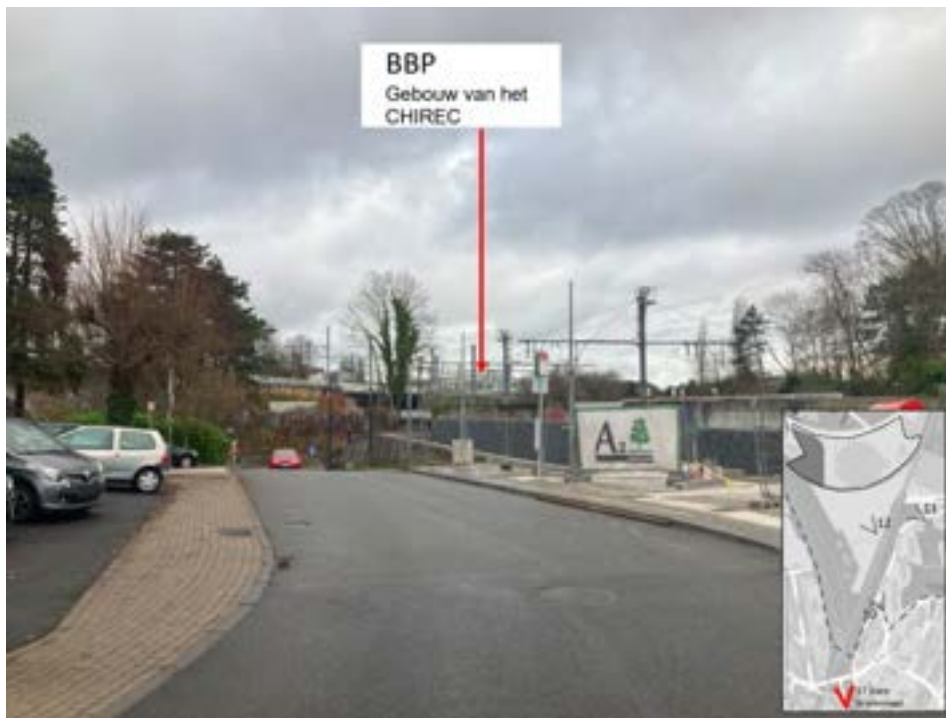
Afbeelding 44 Zicht nr. 17 (afb. CSD Ingénieurs, september 2023)
