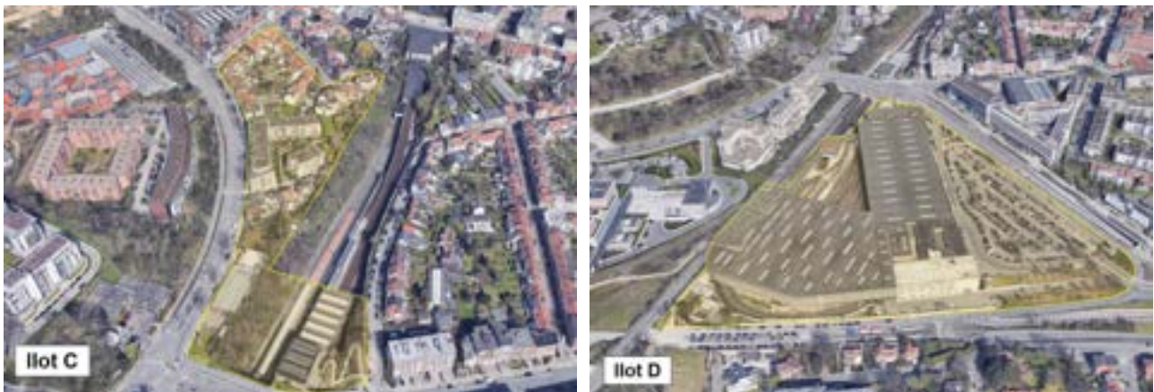
Figure 11 : Vue aérienne des îlots C et D (fond de plan : Google Earth ; ill. CSD Ingénieurs, 2023)
