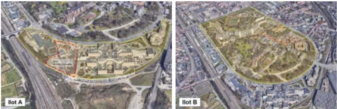
Figure 10 : Vue aérienne des îlots A et B (fond de plan : Google Earth ; ill. CSD Ingénieurs, 2023)
